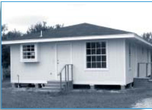
One of Proyecto Azteca's Cascaron House Kits under construction.
